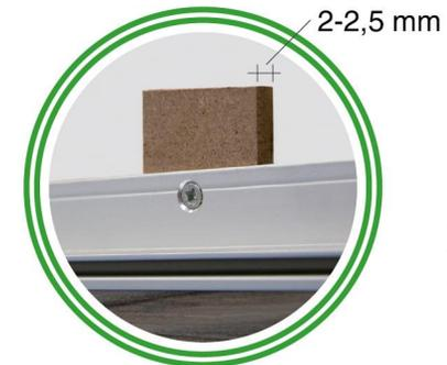
**2** FMH tassellato a muro su distanziale da 2-2,5 mm per l'allineamento con i profili NB laterali
